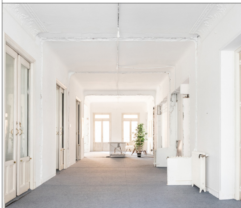
Propiedad Sophiq demolida
