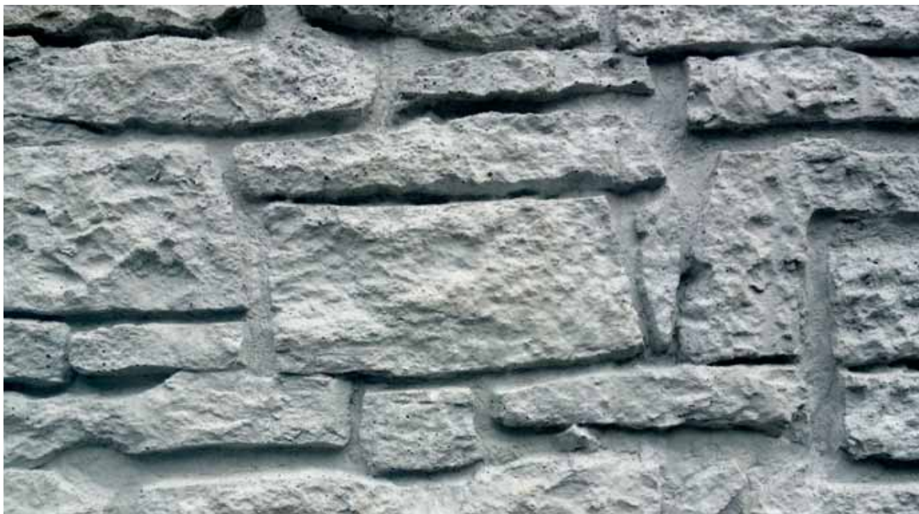
Detail povrchové úpravy s vloženou maticí
