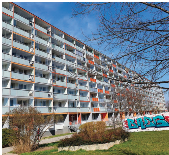
Praha Milánská 412 po rekonstrukci
