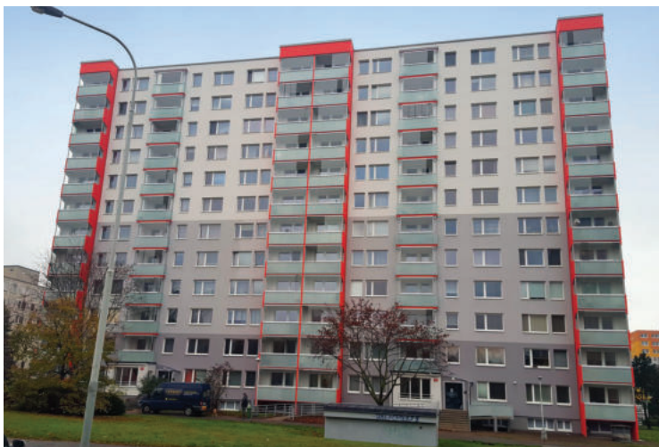
Praha Rilská po renovaci
