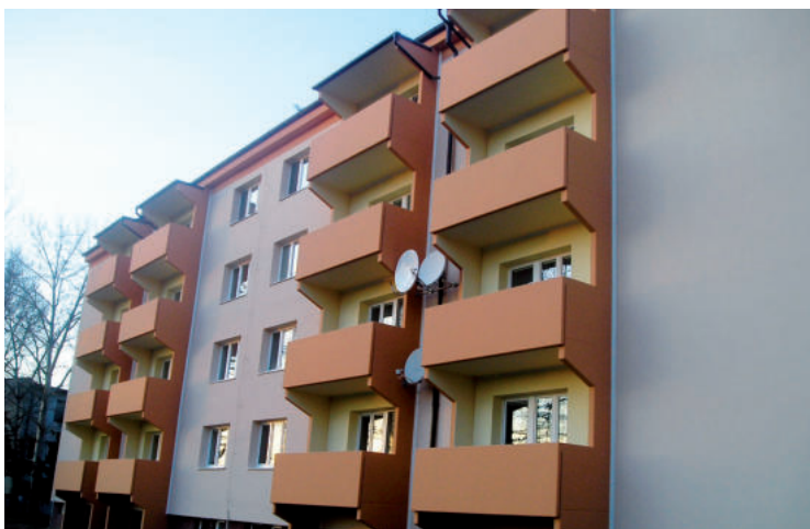
Uherské Hradiště po rekonstrukci
