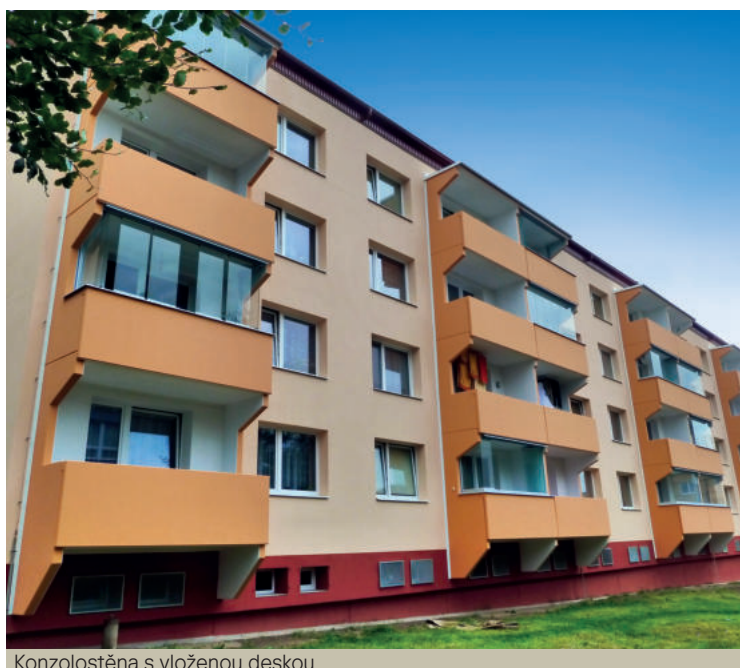
Konzolostěna s vloženou deskou
