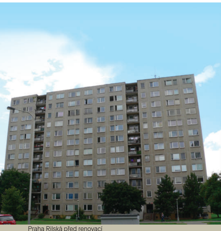
Praha Rilská před renovací
