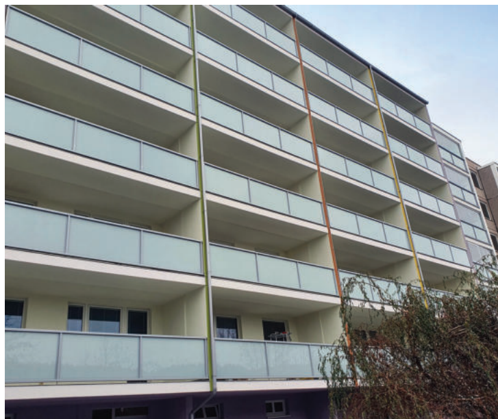
Praha Amforova po rekonstrukci
