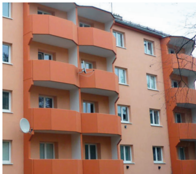
Tvar zalomený se stěnou vybranou
