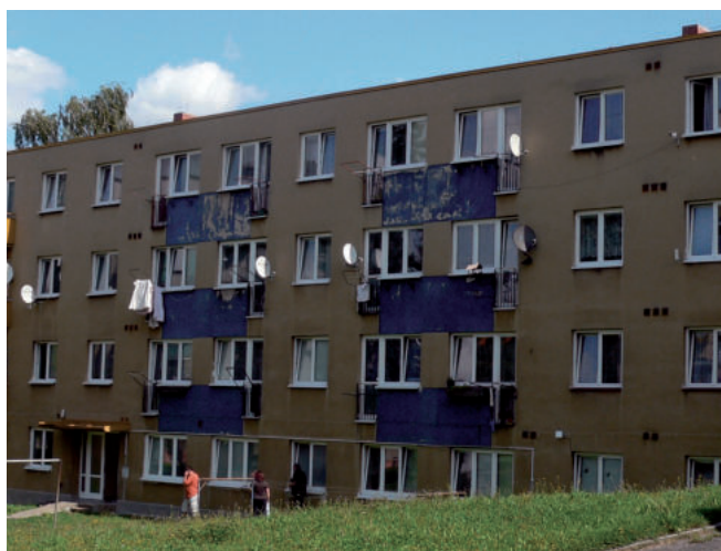
Dobříš před rekonstrukcí
