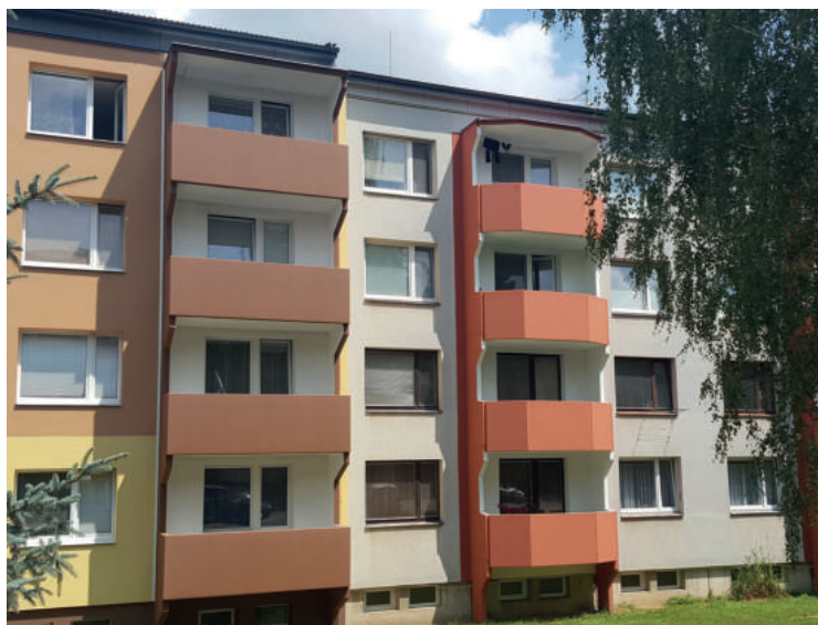
Konzolostěna s vloženou deskou
