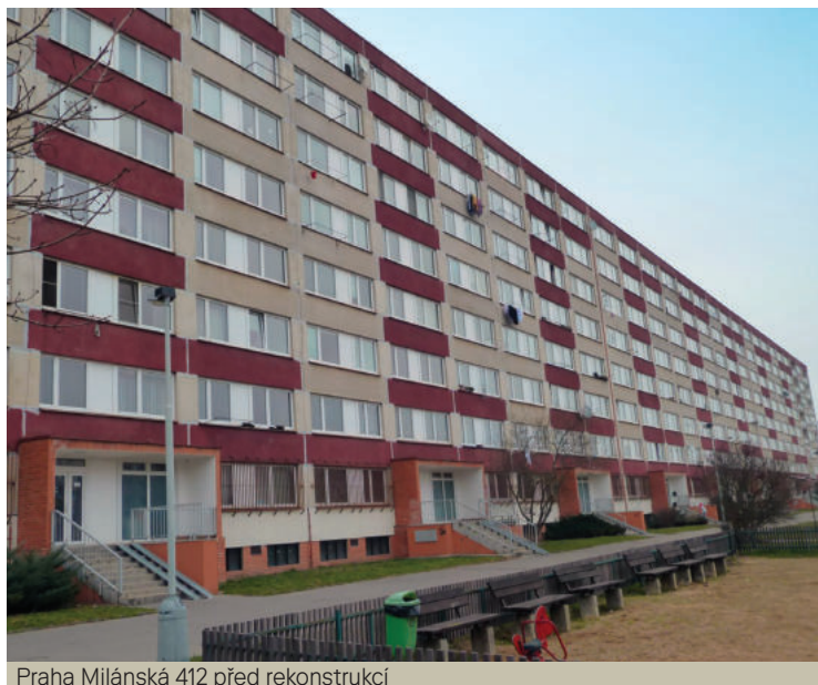
Praha Milánská 412 před rekonstrukcí
