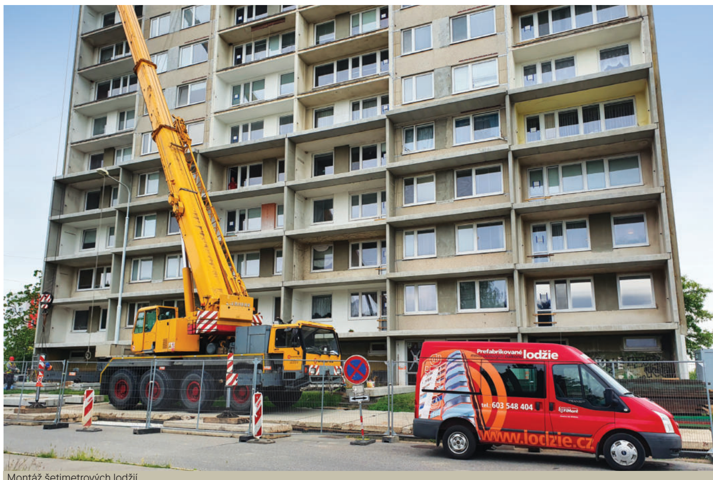
Montáž šestimetrových lodžii
