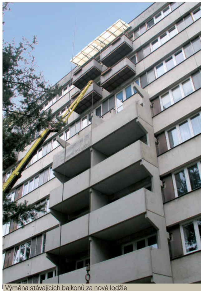
Výměna stávajících balkonů za nové lodžie
