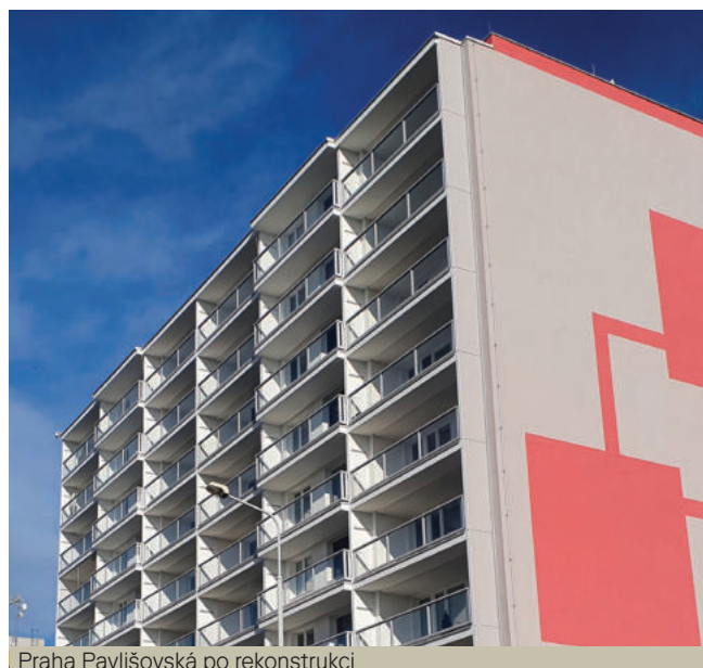
Praha Pavlišovská po rekonstrukci
