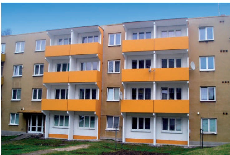
Dobříš po rekonstrukci
