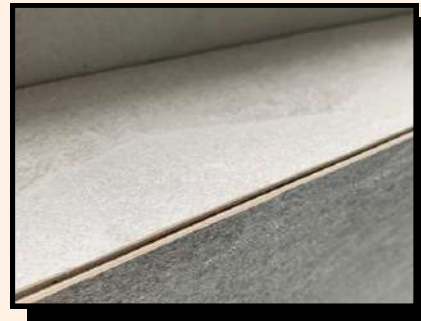
MITRED EDGE JOINING
