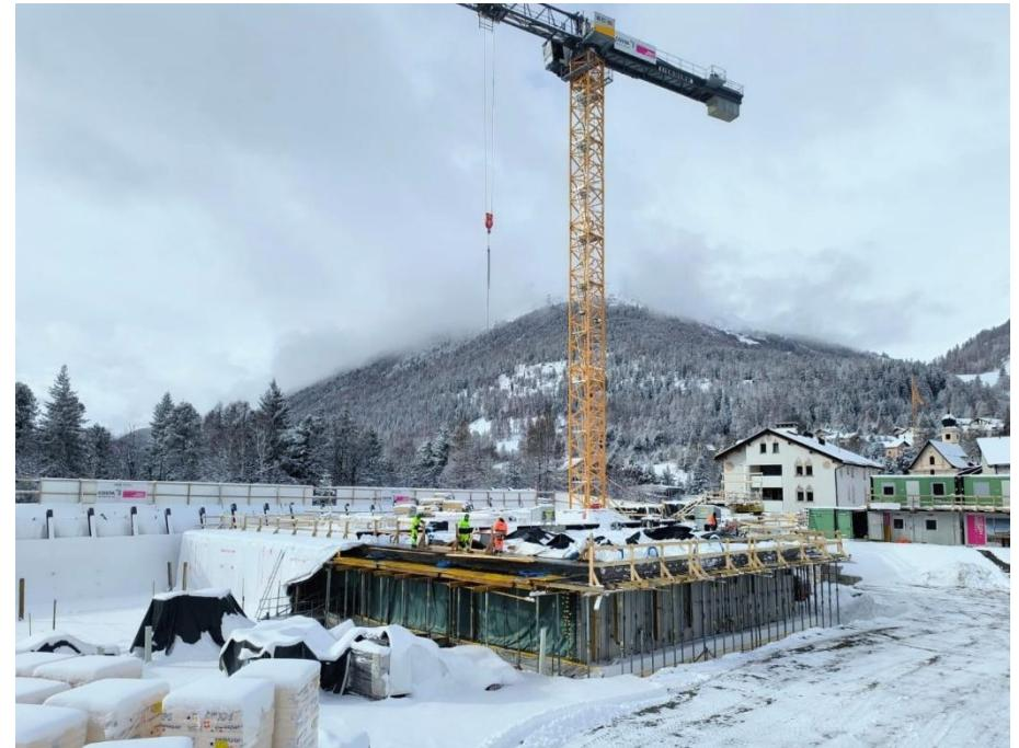
Verwendung von Isolationsmatten und speziellen Thermofolien, um den Rohbau vor extremer Kälte zu schützen.
