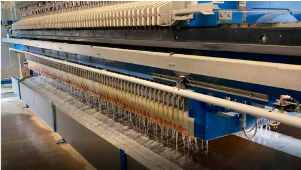
»4: Combined water/solid recycling using a state-of-the-art chamber filter press »4: Kombiniertes Wasser-/Feststoffrecycling mit hochmoderner Kammerfilterpresse
