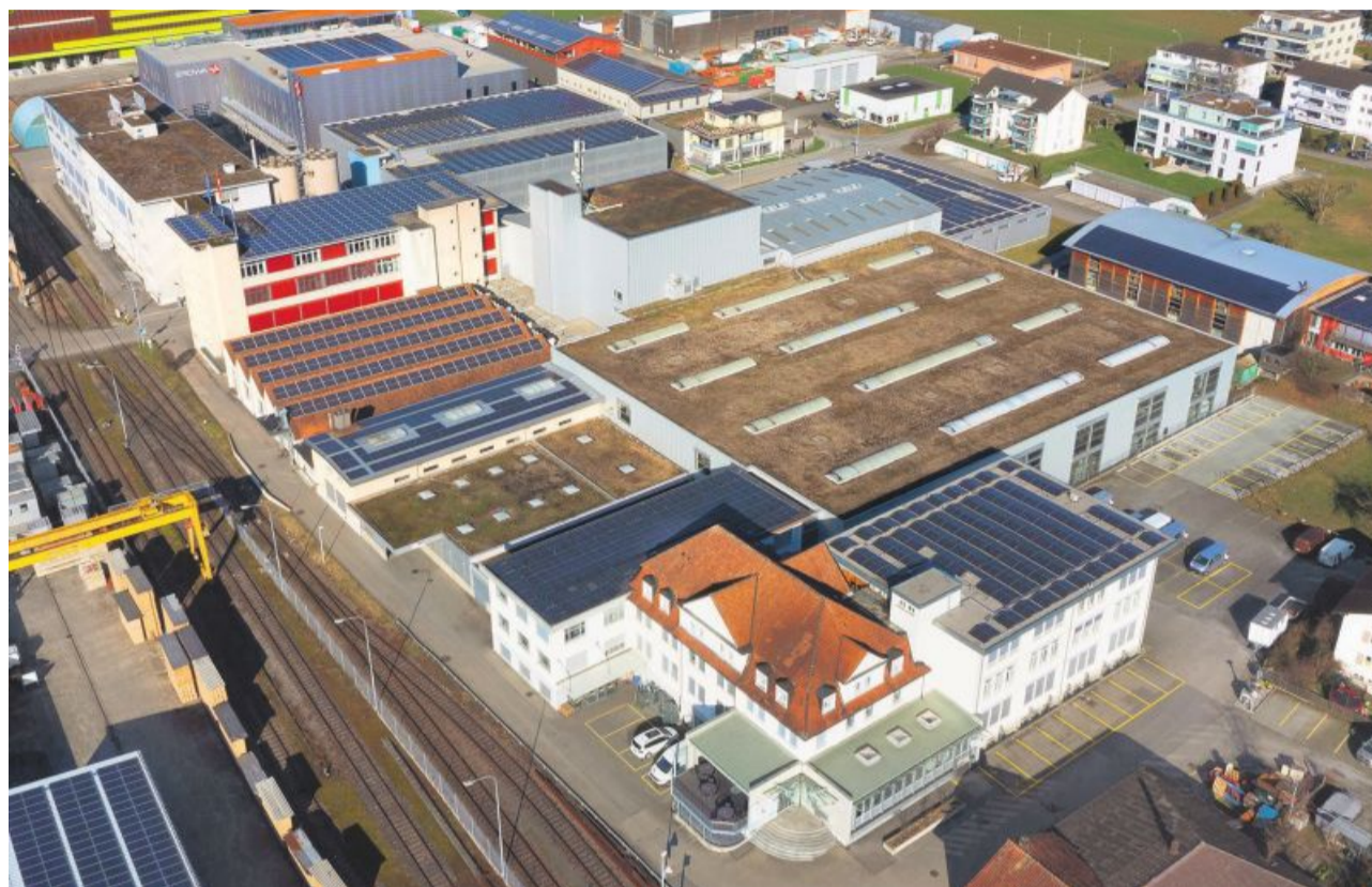
Die ATO Immobilien- und Handels AG bewirtschaftet in Büron ein fast 30'000 Quadratmeter grosses Areal.
