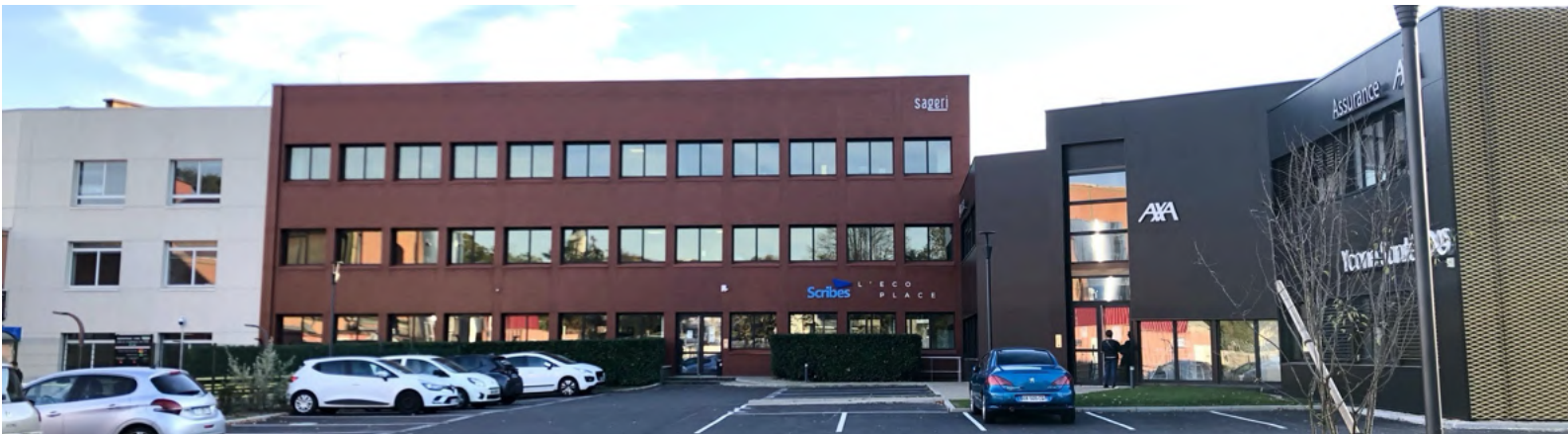
Photos Bureaux - Bâtiment C
