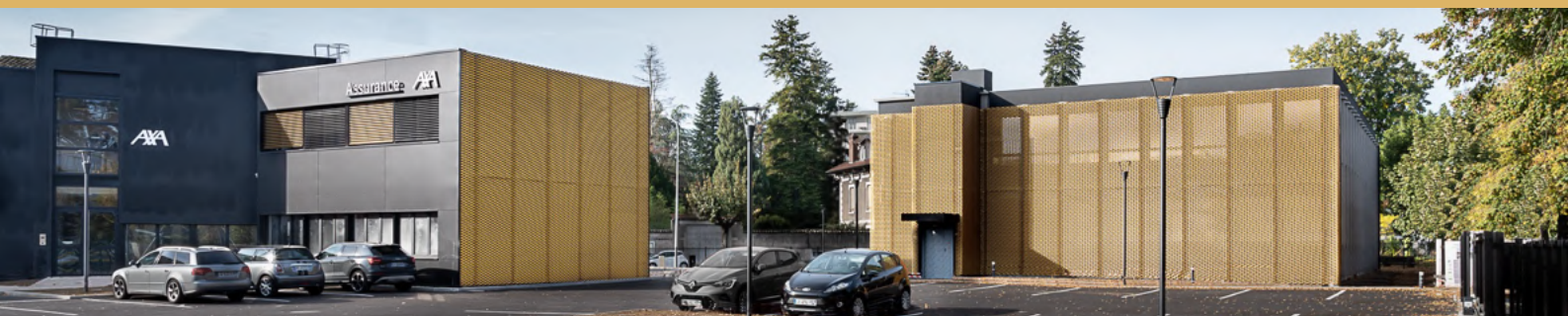
Photos Bureaux - Bâtiments A et B
