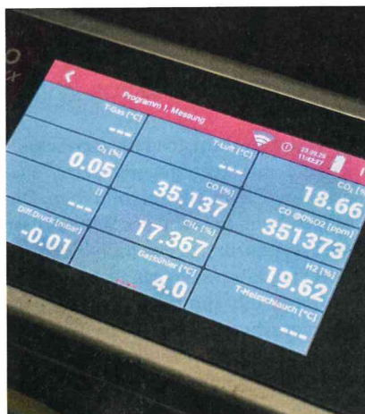
△ Die Anlage kann aus Holz hackschnitzeln ein brennbares Gas erzeugen.
