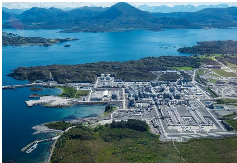
Die norwegische Gasverarbeitungsanlage Nyhamna auf der gleichnamigen Halbinsel an der Westküste Norwegens verfügt über eine Kapazität von 79,8 Mio. Kubikmetern/Tag, von denen 69,8 Mio. Kubikmetern/Tag aktuell ausgefallen sind. (Bildquelle: Aker Solutions)
