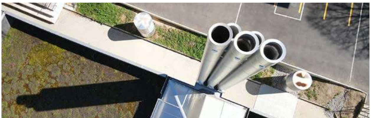
Abb. 1: Die Holz-Heizzentrale «Neuallschwil».
