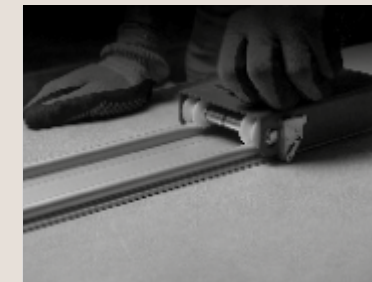
Cutting detail with guide on slab. Detalle de corte con guía sobre plancha.
