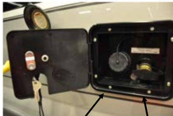
1 2 PHOTO D-2 Entrées d'eau
