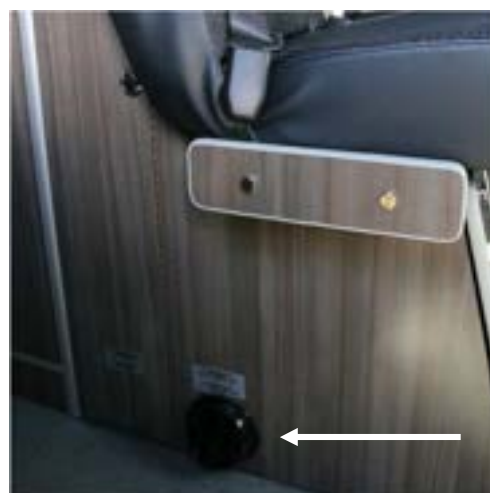
PHOTO E-66 Bouche d'air chaud
