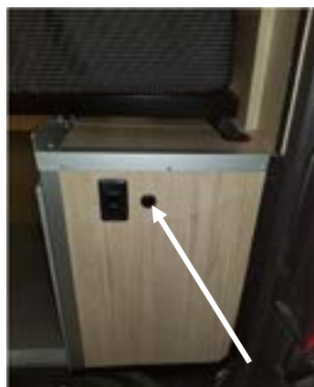
PHOTO E-43 Interrupteur pour lumière dans l'espace cargo, situé à l'arrière
