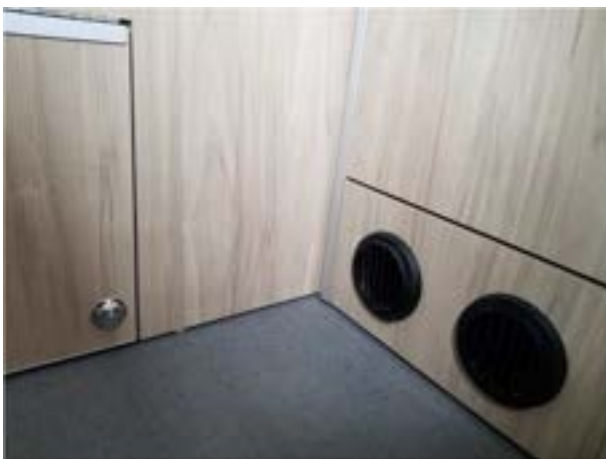
PHOTO E-65 Bouches d'air chaud à l'intérieur du véhicule
