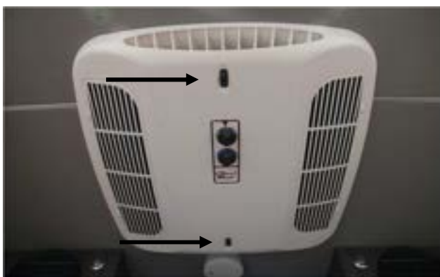
PHOTO F-8 Boutons de contrôle des bouches d'air
