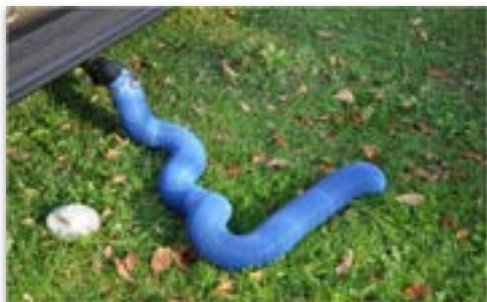
PHOTO D-36 Branchement à une station de vidange (sans adaptateur)
