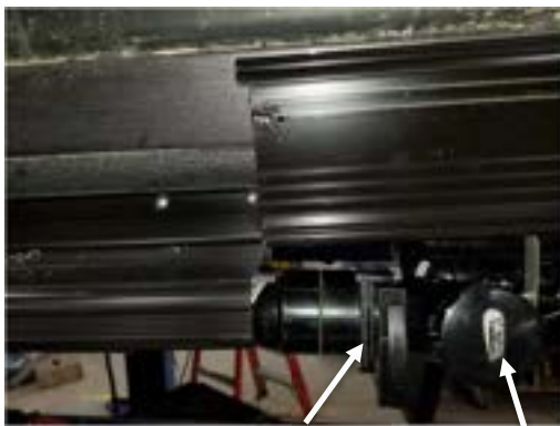
1 2 PHOTO D-30 Vidange des eaux usées
