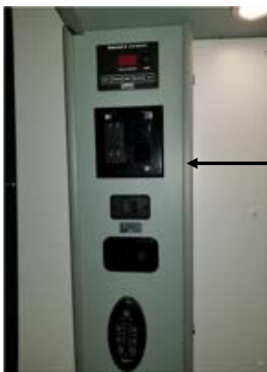
PHOTO C-6 Interrupteur de sélection (microondes ou prise 1)
