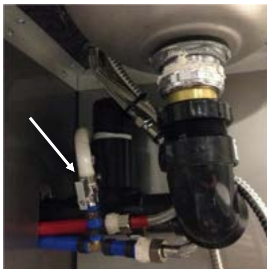
PHOTO D-29 Valve sous l'évier pour couper le circuit de plomberie
