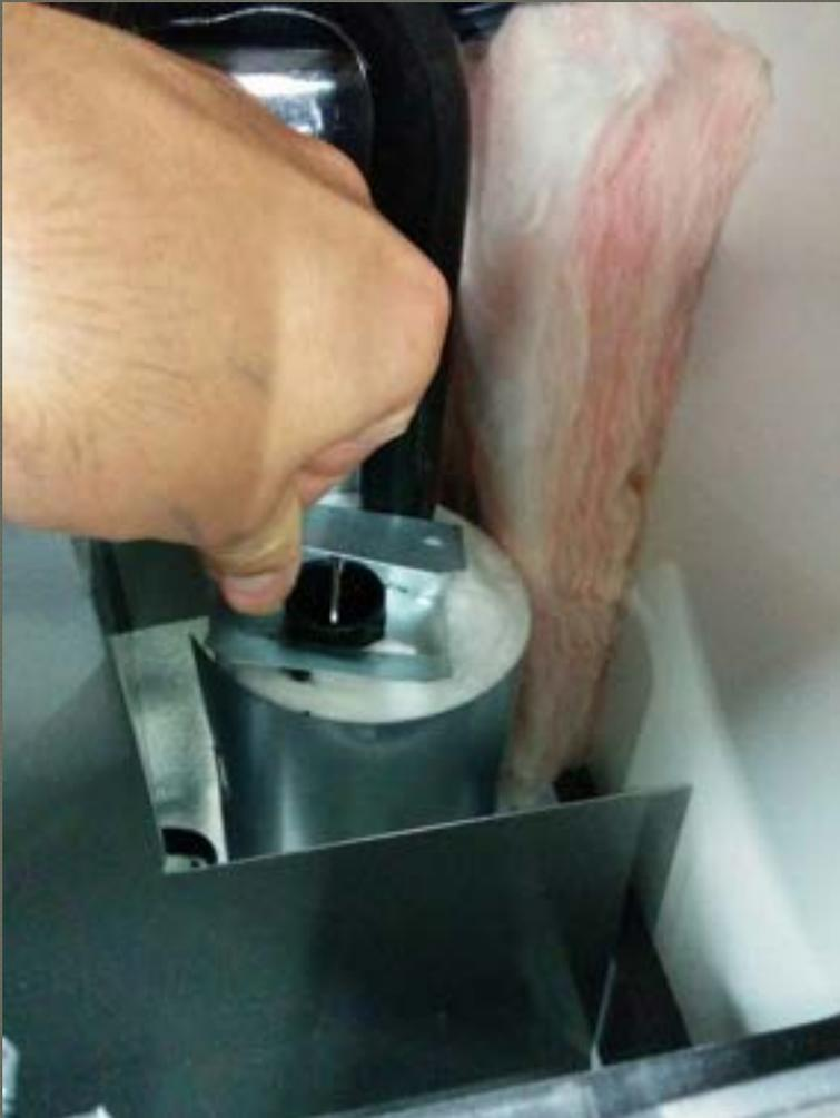
Avec le temps, des particules de rouille s'accumulent dans la chambre à combustion et sur le brûleur. Cette zone doit être nettoyée par un professionnel tous les deux ans
