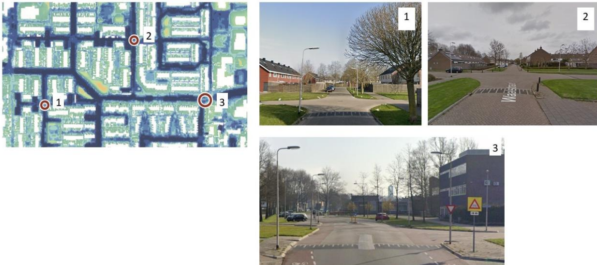
Figuur 41. Bestaand groen ligt hoger dan de straten, waardoor water niet kan infiltreren in de bodem. Drempels houden afstromend water tegen
