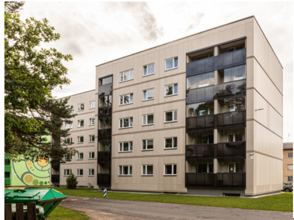
Промислово відремонтований багатоквартирний будинок у Камбі, Естонія. Джерело: KMT Prefab
