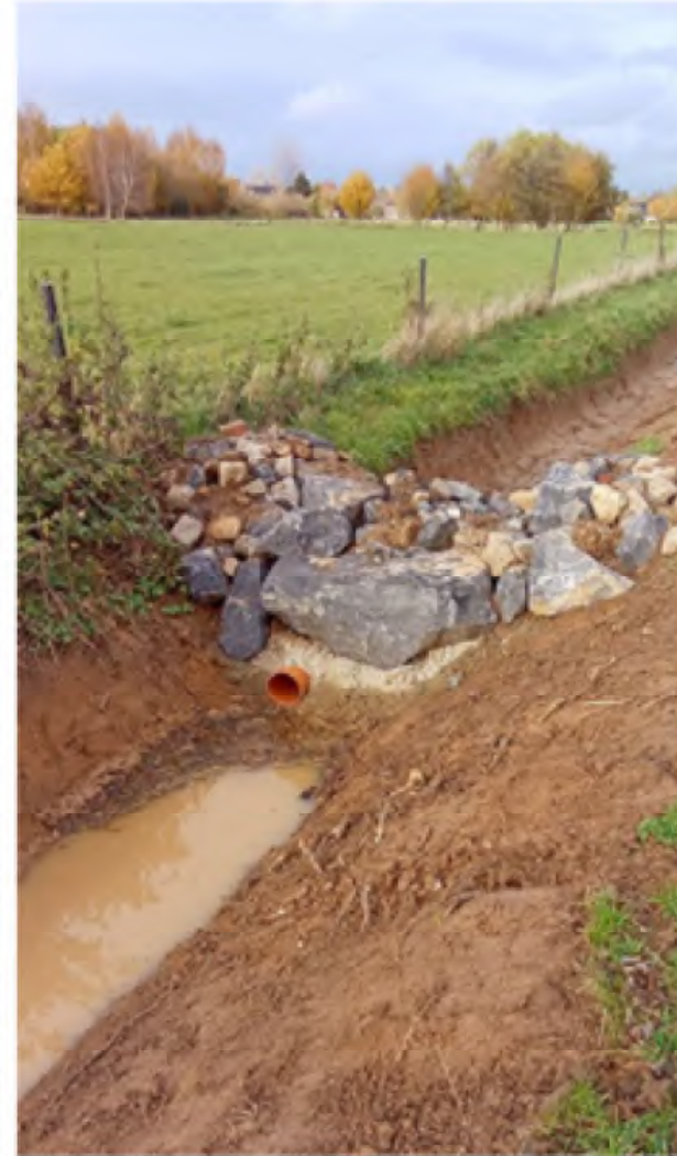
Exemples de noues avec redent en milieu agricole
