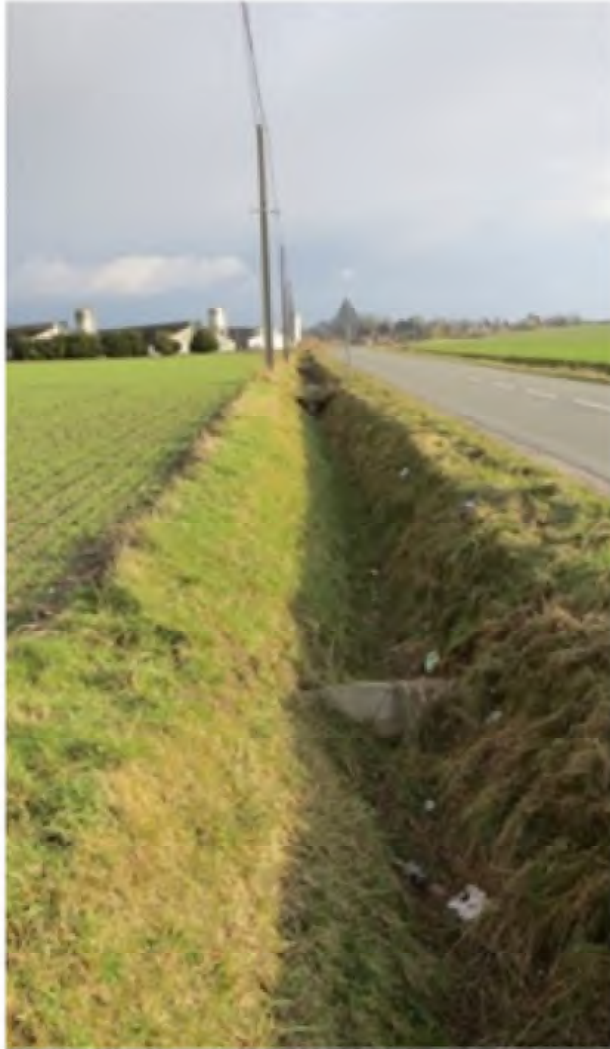
Exemples de noues avec redent en milieu agricole
