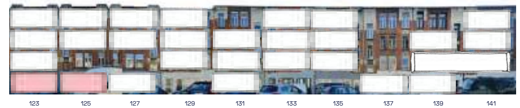
Situatie Confortablok in februari 2025 (26+2 aangekocht)
