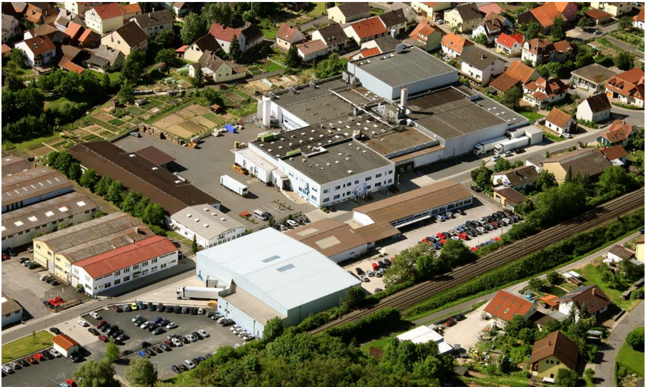
Am Standort in Schweigern wird der Wasserverbrauch genauer erfasst.
