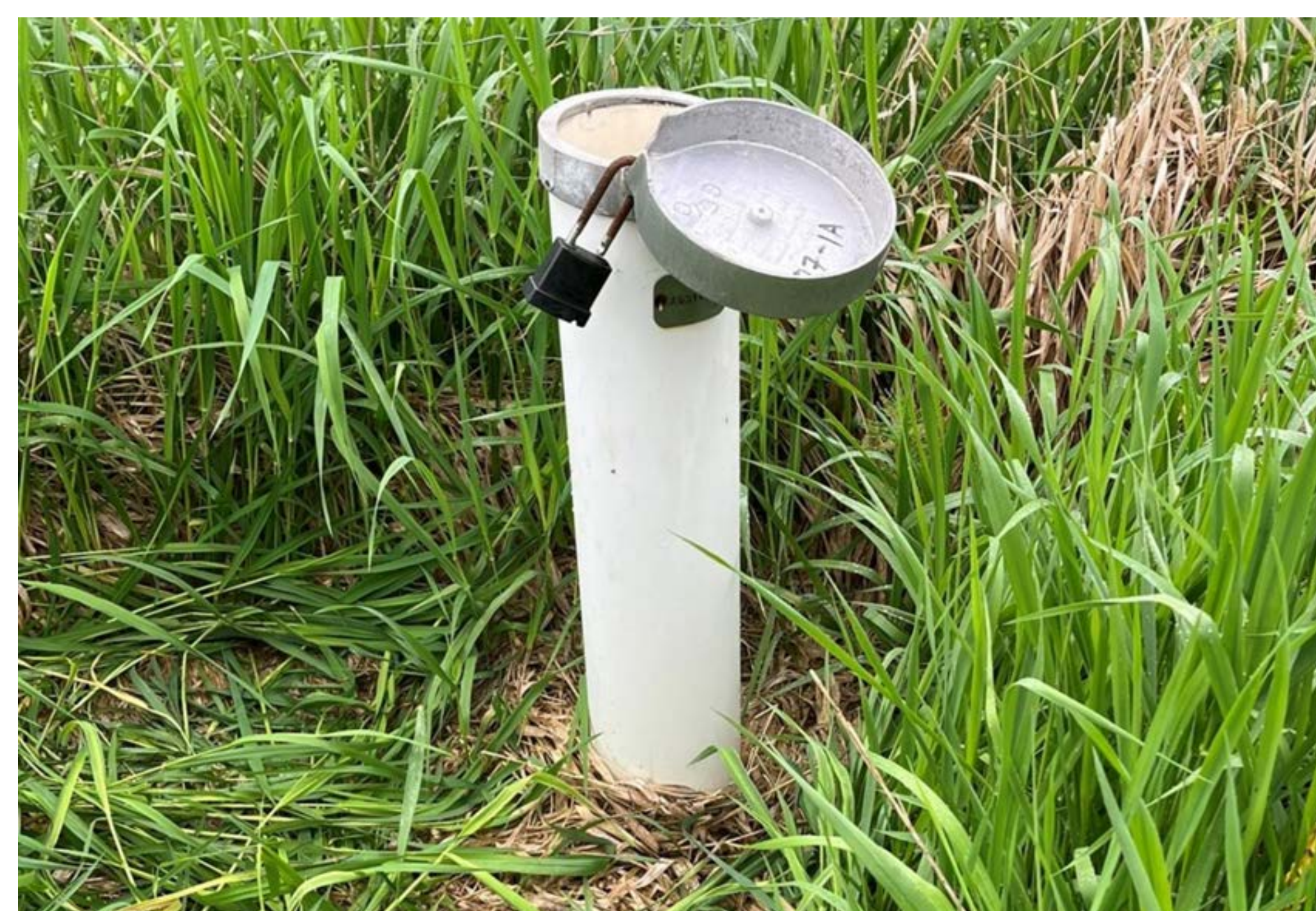
Puits de surveillance des eaux souterraines typique
