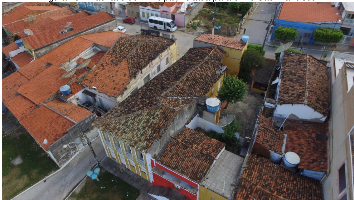
Figura 18 – Fachado do Principal, voltada para o Rio São Francisco.
