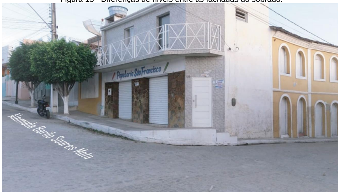
Figura 15 - Diferenças de níveis entre as fachadas do sobrado.
