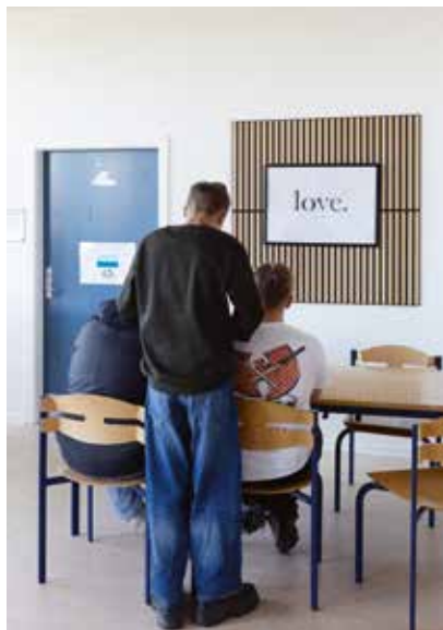
Akustikpaneler i træ er sat op flere steder på gangarealer og i fællesrum for at sænke lydniveauet.
