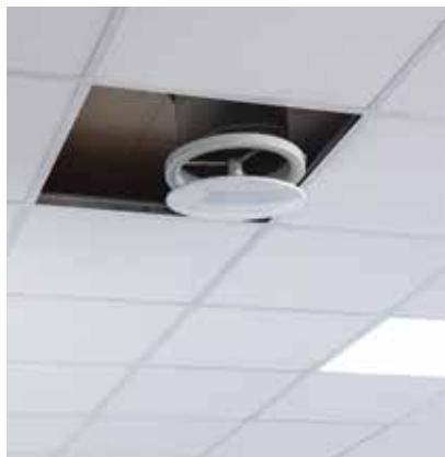
Efter sommerferien tændes der for det nye mekaniske ventilationssystem på Torslev Skole. Det ser både ledere, lærere og elever frem til.
