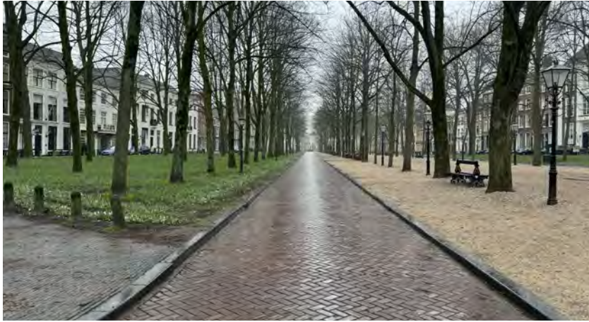
Hiërarchische opzet in het straatprofiel. Per functie is er sprake van veranderende straatafwerking, beplanting en kleurstelling. De middenberm voor voetgangers is afgewerkt met schelpen. De smalle straten voor het autoverkeer in rode klinkers, de brede trottoirs in smalle klinkers in wisselende patronen. De smalle langgerekte grasvlakken vormen op de lange as een buffer tussen doorgaand autoverkeer en bestemmingsverkeer op de ventwegen. Op de korte as zijn deze vlakken niet met gras maar met klinkers bedekt.
