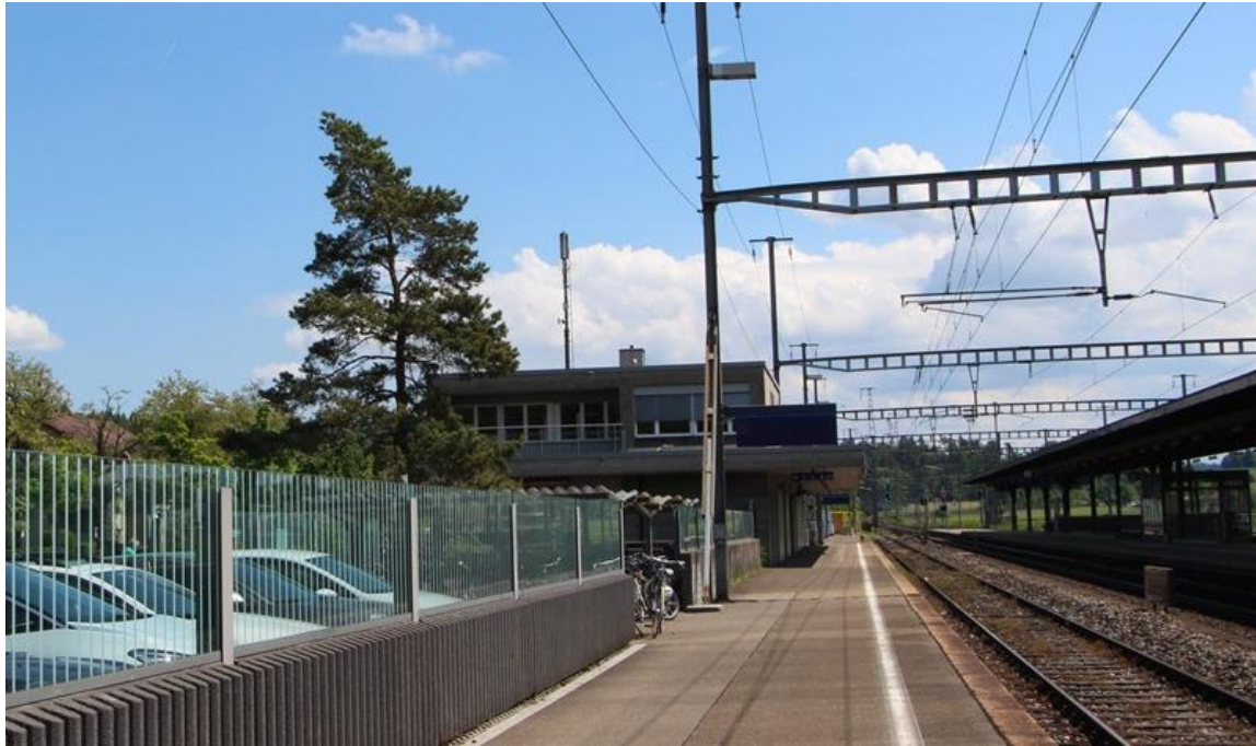
Vorher (Bahnhof Bassersdorf)
