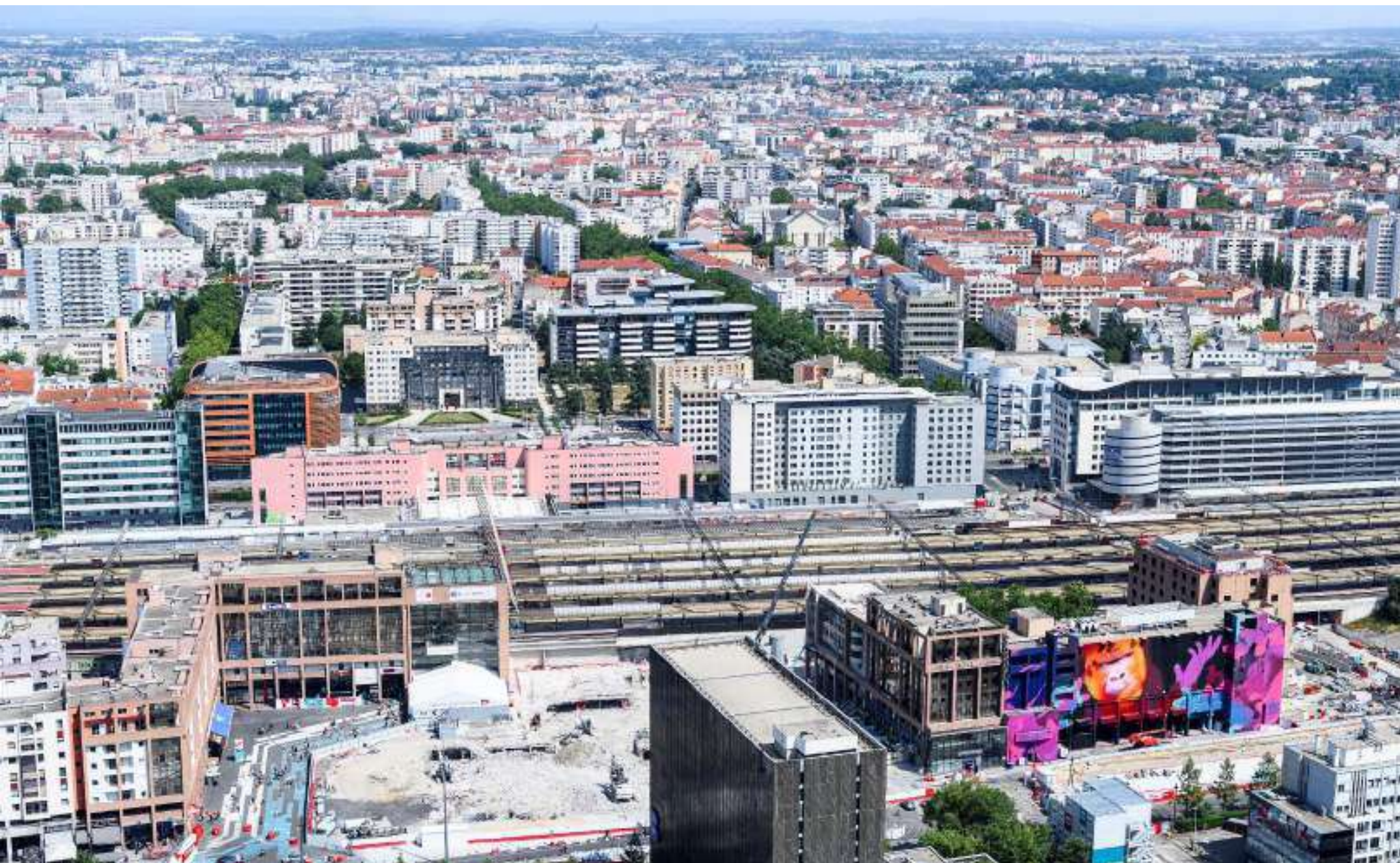
Démolition near railways : by « écrétage »...
