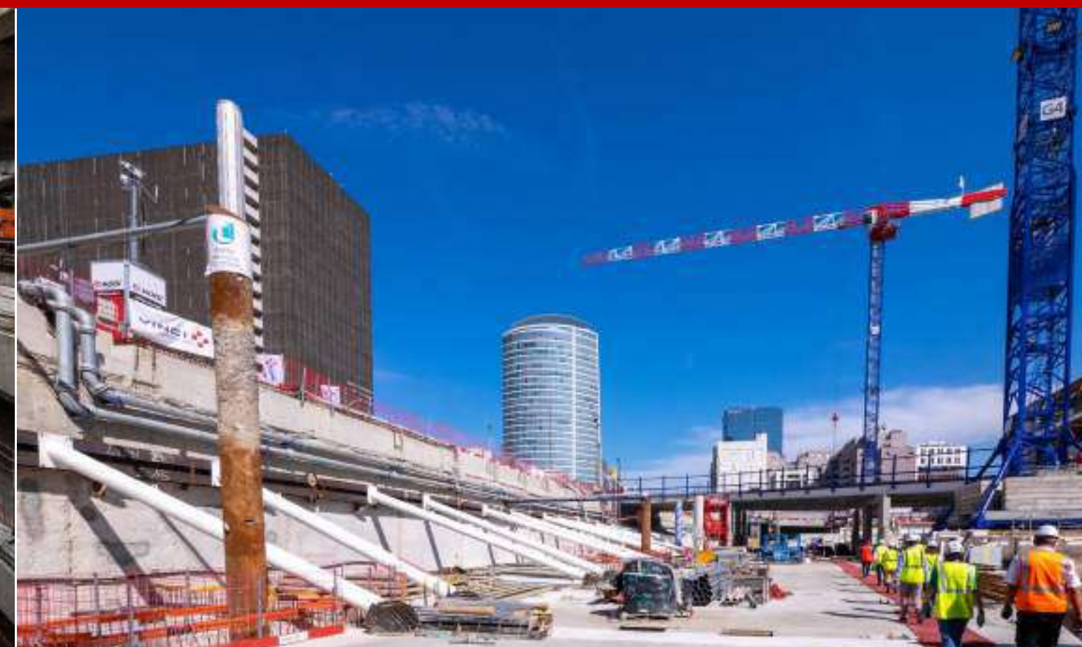
A construction « en taupe » for the underground facilities
