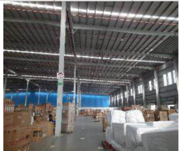
64) Subject Asset – Internal Visual
