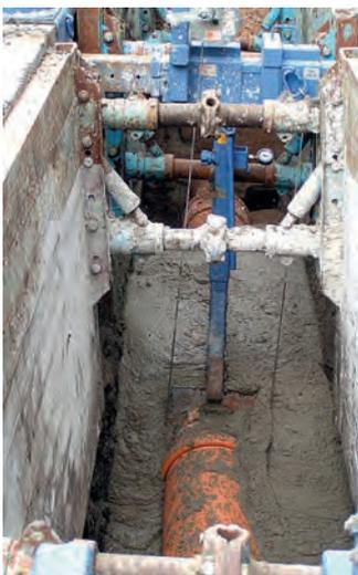
*Einbau in Flüssigboden, der das Rohr nahtlos umschließt. Nach der eigenständigen Verfestigung gibt es kein Nachsacken des Bodens – spätere Straßeneinbrüche sind ausgeschlossen.*
