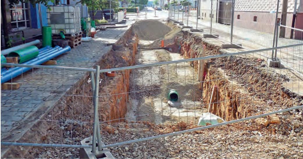
Die klassische Einbauweise in Sand und Kies mit mechanischer Verdichtung.
