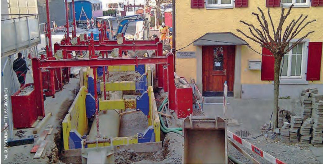
*Dank der schmalen Grabenbreite ist der Tiefbau mit Flüssigboden selbst in den engsten Straßenabschnitten möglich.*
