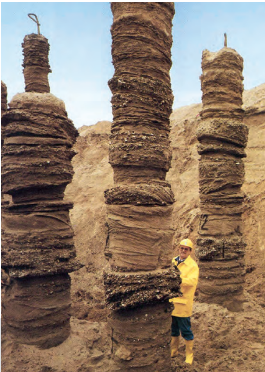
Kiessand: homogen? Injektionskörper bei Düsenstrahlverfahren
