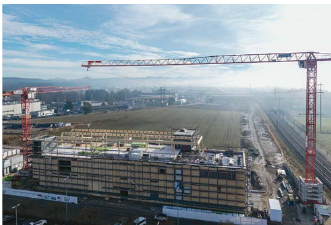
Innert zehn Monaten wurde der Rohbau der Energiezentrale in Volketswil erstellt. Die Rechenzentren kommen auf der Parzelle dahinter zu stehen.
