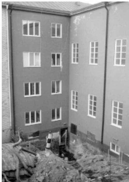
En del sprängningsarbeten utfördes innan tillbyggnaden kunde påbörjas.
