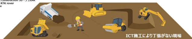
ICT施工により丁張がない現場
