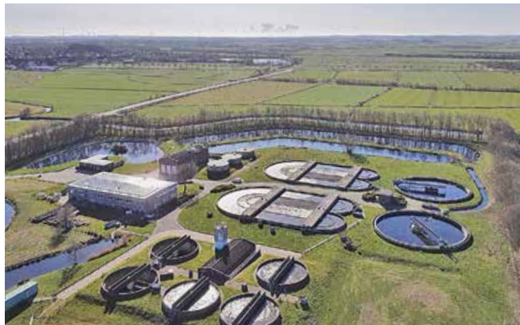
In Husum darf bei der Abwasserentsorgung wegen der sensiblen Umwelt nichts schiefgehen.
