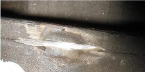
Soldar después del corte
