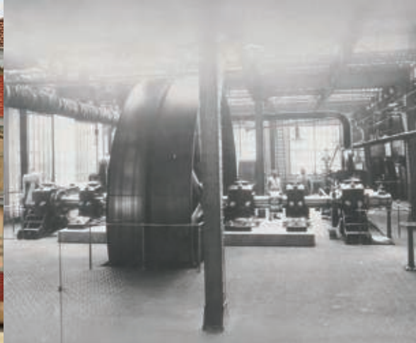
En 1887, la vapeur alimente cette puissante machine Corliss, qui fournit 300 chevaux-vapeur. ©CAAPC
