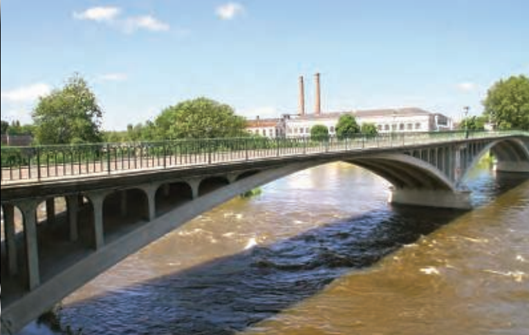
L'utilisation du béton armé pour la construction du pont de la Manu lui procure finesse et légèreté. ©N. Mahu
