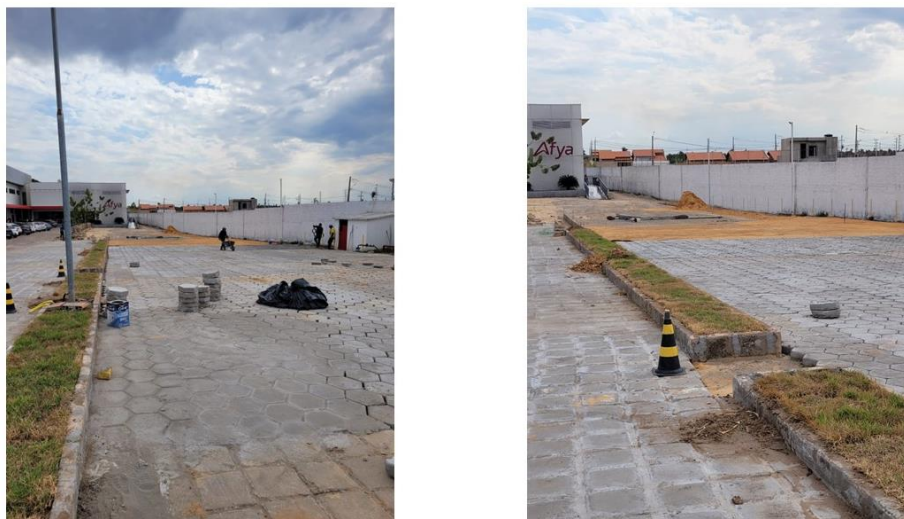
Figura 6 - Reforma do estacionamento
