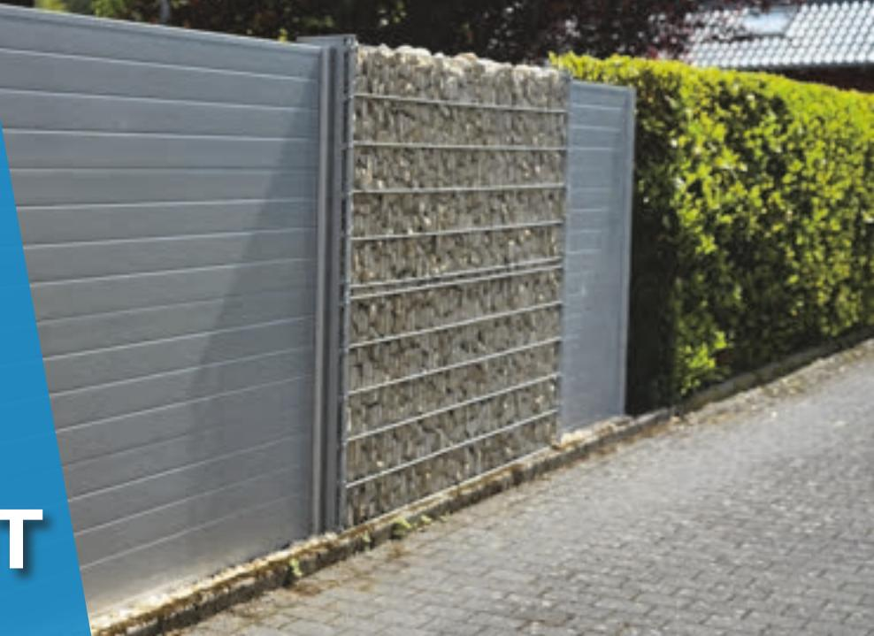
Gabionen sorgen für Stabilität, Lärmschutz und eine kraftvolle Optik. In Kombination mit paneello® Flächenelementen entstehen ruhige, elegante Zaunverläufe mit architektonischem Anspruch. Auch Mauerpfleiler lassen sich harmonisch integrieren und setzen zusätzliche Akzente.
