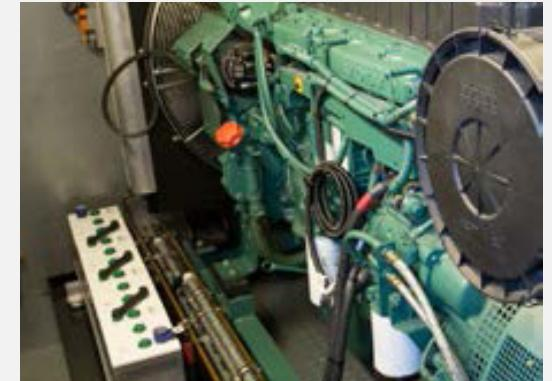
Der Diesel-Generator von Volvo Penta treibt mit einer Leistung von 600 PS den Notstromgenerator an. Dieser gewährleistet die Stromversorgung unseres Abrechnungszentrums ohne jegliche Einbußen bei der Abrechnungskapazität. Er startet automatisch innerhalb von 20 – 30 Sekunden und hat theoretisch eine unbegrenzte Laufzeit.
