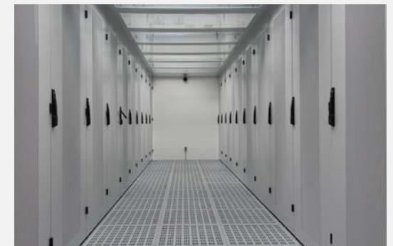
Das Herz der Anlage: Der Serverraum. Hier werden alle Geschäftsprozesse verarbeitet. Nach Detektion von feinsten Rauchschwaden wird der Raum mit einem technischen Löschgas geflutet, welches in der Wirkung den Sauerstoffgehalt auf ein Niveau reduziert, in dem keine offene Flamme mehr möglich ist.
