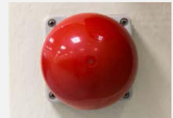
Der Taster öffnet die Türen zu den Scannerräumen kurzzeitig zum Durchschreiten, da diese im Normalfall aus Brandschutzgründen über eine Automatik geschlossen und verriegelt sind.
