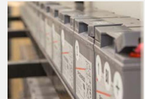
Mehrere Hochleistungsakkus in zwei voneinander unabhängigen und somit redundanten unterbrechungsfreien Stromversorgungen sorgen für eine Zwischenpufferung der relevanten Systeme für bis zu 30 Minuten.
