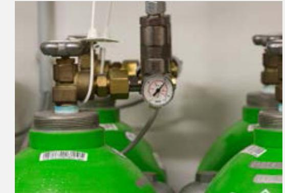
Die Löschanlage wird zur unbedingten Sicherstellung der Funktion – selbst bei Stromausfall und gleichzeitigem Versagen des Generators – mit in Druckflaschen bevorrateter Druckluft angetrieben.
