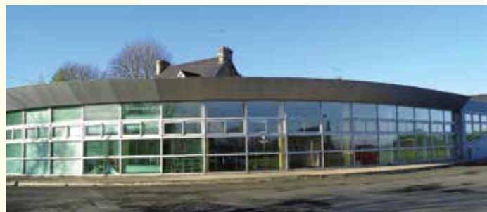
Restaurant scolaire : rénovation thermique à réaliser
