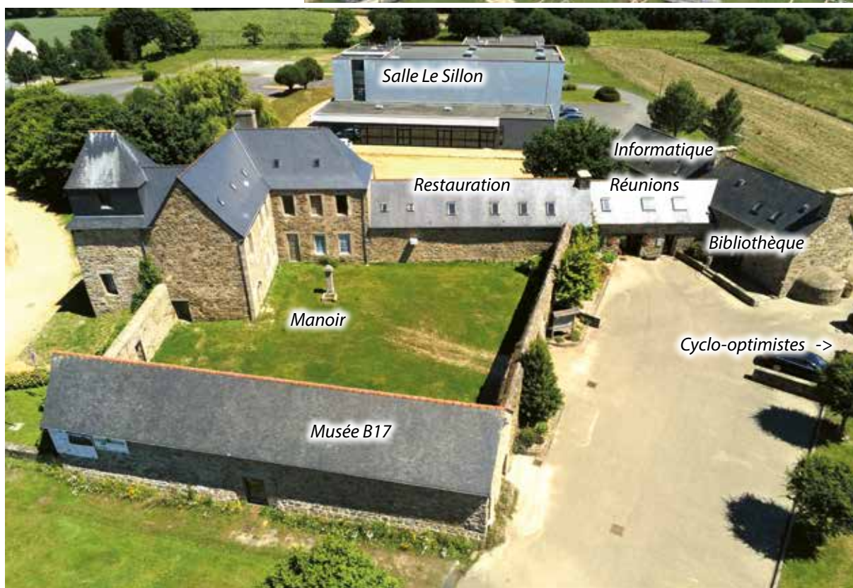
Mise hors d'eau du Manoir
