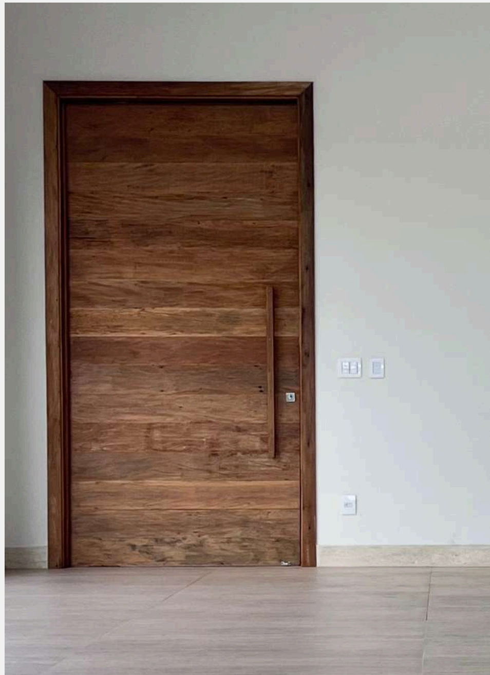
Porta de entrada de madeira de demolição - 1,50m de largura x 2,50m de altura - revestimento externo em ripado
