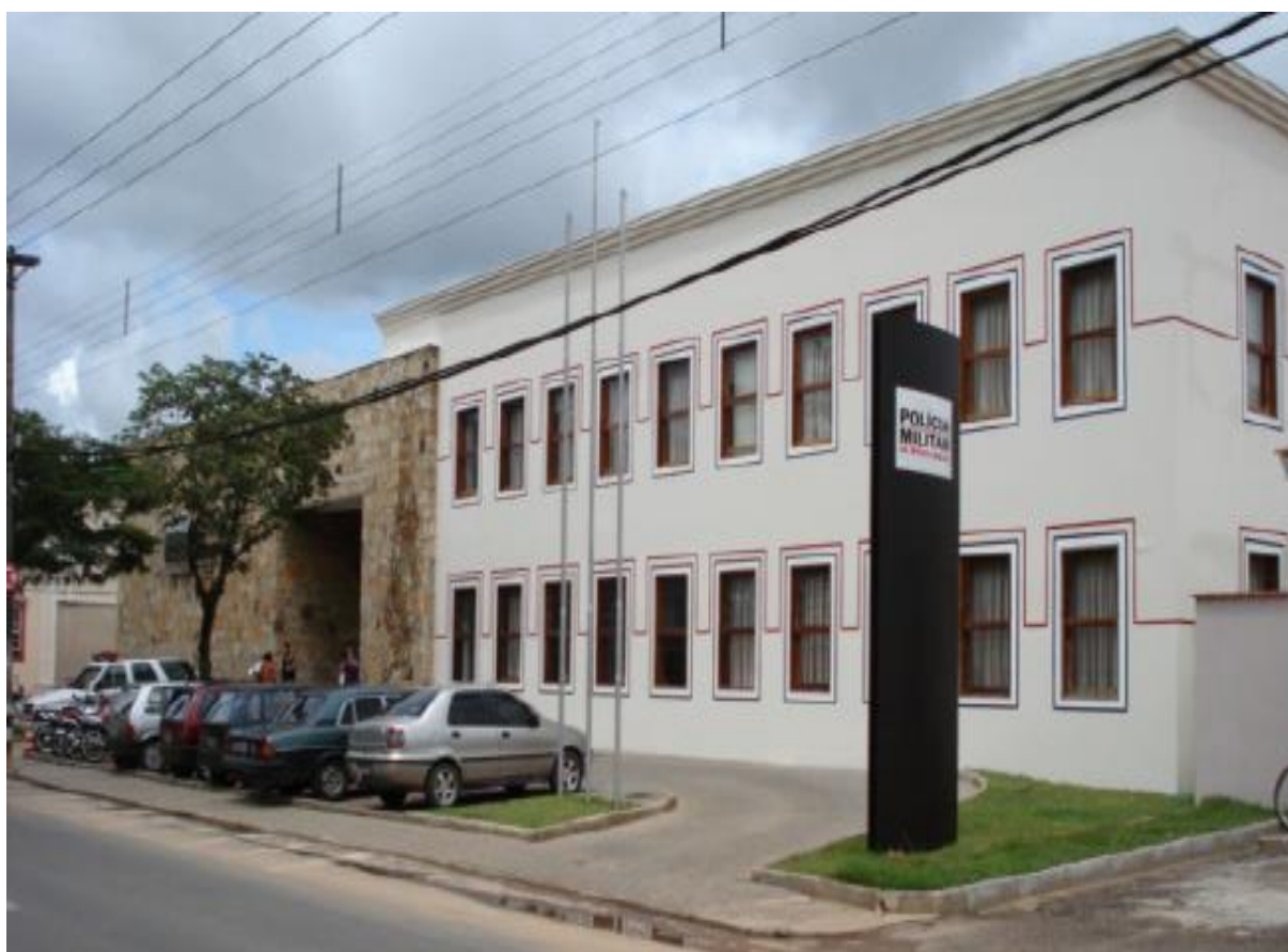
FIGURA 1 – Sede do 38º Batalhão de Polícia Militar do Estado de Minas Gerais, instalado no Município de São João del-Rei (MG)
