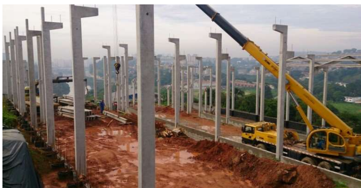
Figura_18 Pilares Prémoldados de Concreto
