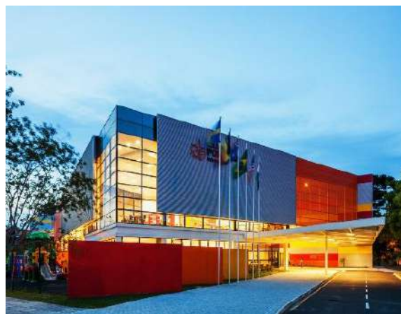
Figura 8- Fachada Colégio Positivo
