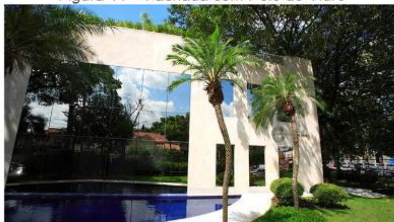
Figura 11 – Fachada com Pele de Vidro
