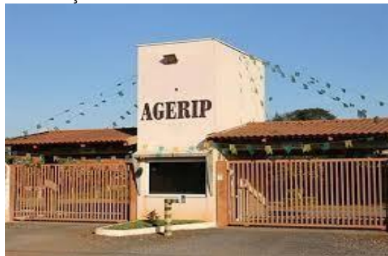
Figura 5 – Vista da fachada da AGERIPE, Associação de idosos.
