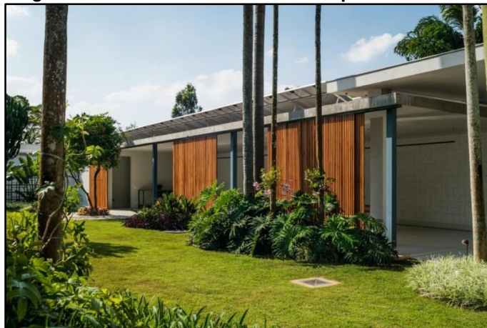
Figura 0: Imagem área externa Residência Campo Belo/ Brises de madeira
