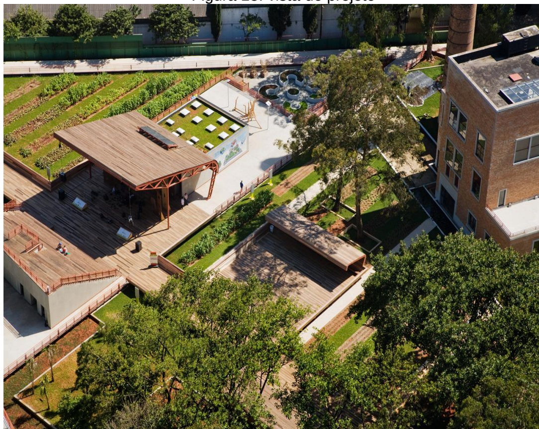
Figura 18: vista do projeto
