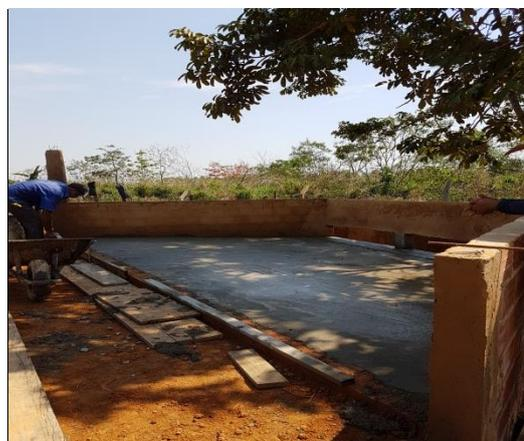
Figura 7 - Nova caixa de recepção em construção. Outubro/2020
