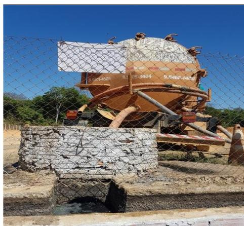
Figura 5 - Descarga na caixa de recepção.
