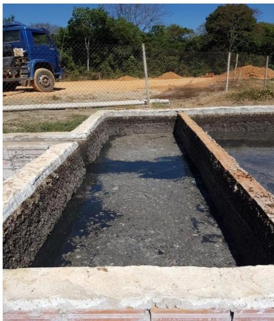
Figura 11 - Entrada do efluente na caixa de gordura, após passar pela caixa desarenadora.
