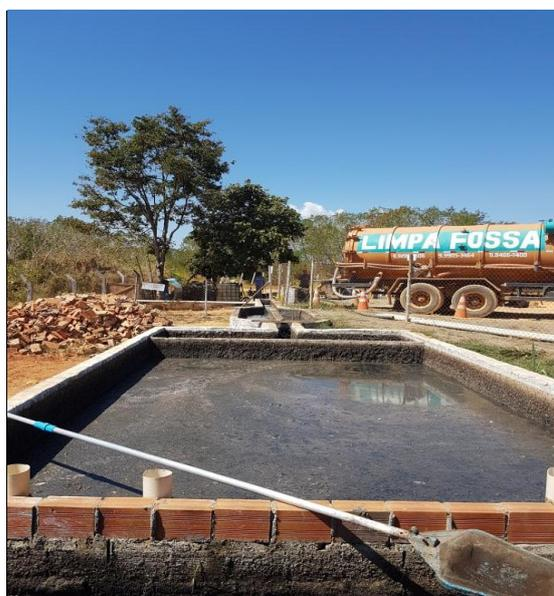
Figura 13 - Caixa de gordura. No fundo a caixa desarenadora.
