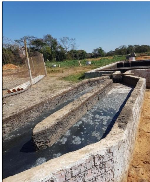
Figura 10 - Caixa Desarenadora/vazão
