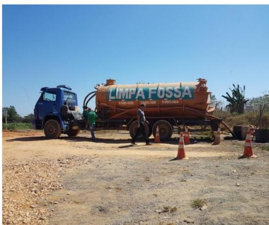
Figura 4 - Caminhão auto fossa descarregando na caixa de recepção.
