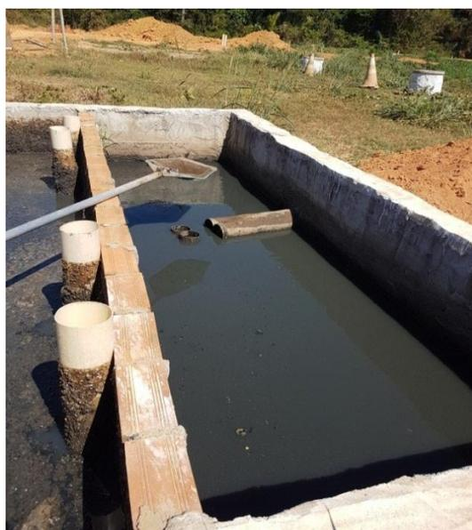
Figura 14 - Saída da caixa de gordura. Peneira para remoção dos resíduos em suspensão.
