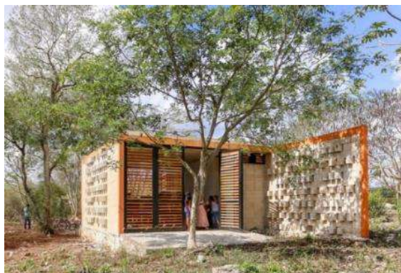
Figura 2 – Fachada do Parque da Ciência Fonte: (ARCHDAILY, 2021)
