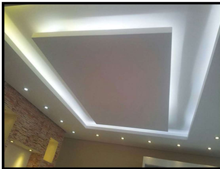
Figura 50: Forro de gesso
