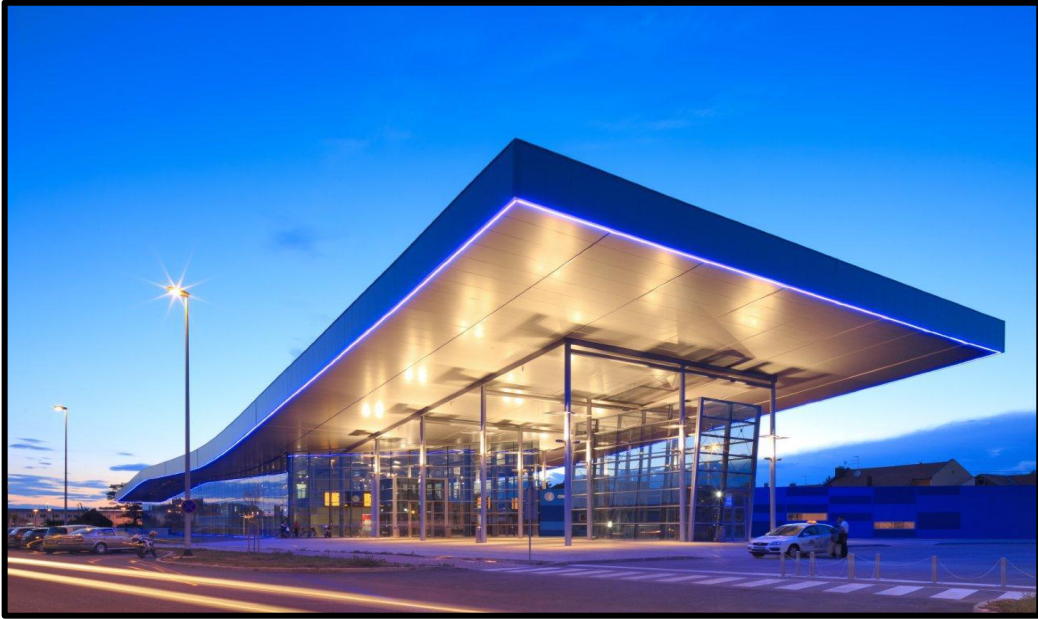
Figura 31. Rodoviária de Osijek.
