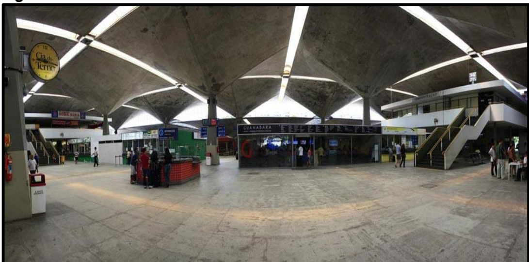
Figura 57. Interior do edifício.
