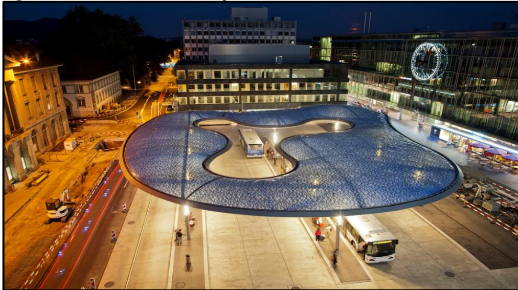
Figura 38. Cobertura da estação.
