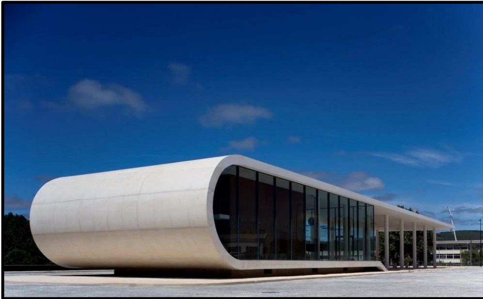
Figura 26. Terminal Rodoviário de Rio Maior.
