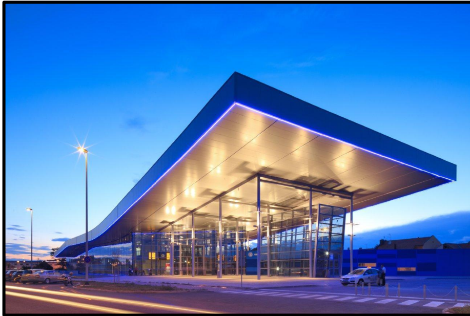
Figura 21. Rodoviária de Osijek
