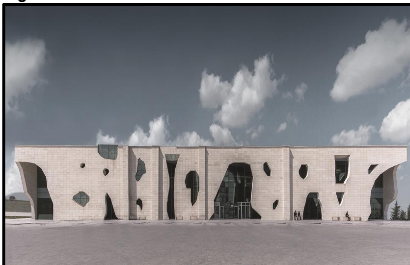
Figura 10. Terminal de Ônibus Nevsehir
