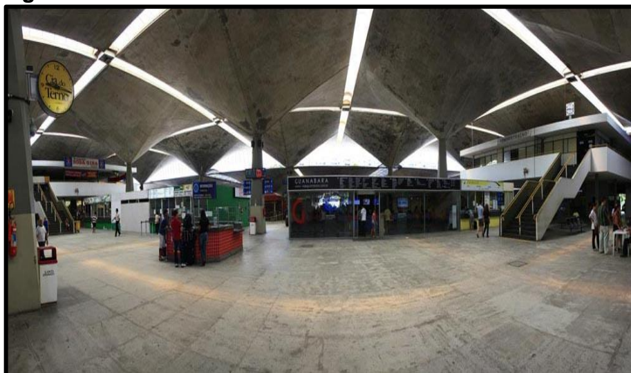
Figura 37. Interior do edifício
