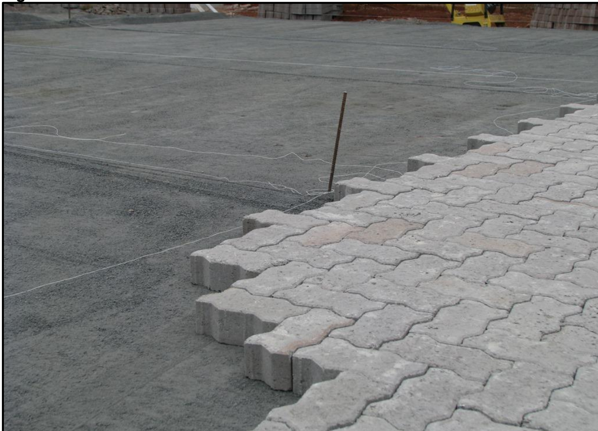
Figura 101. Piso de bloco intertravado.
