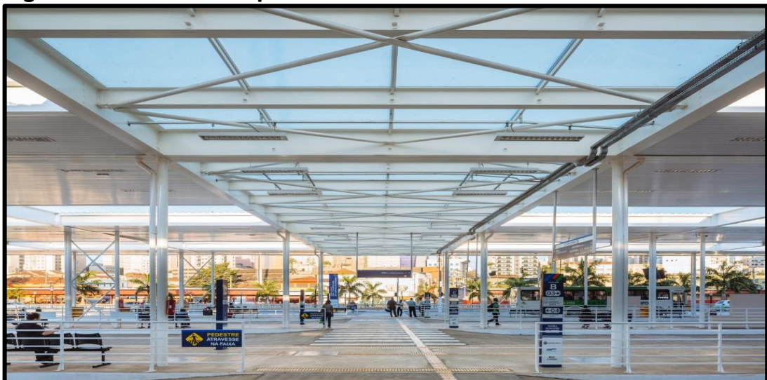
Figura 60. Travessia de pedestres.
