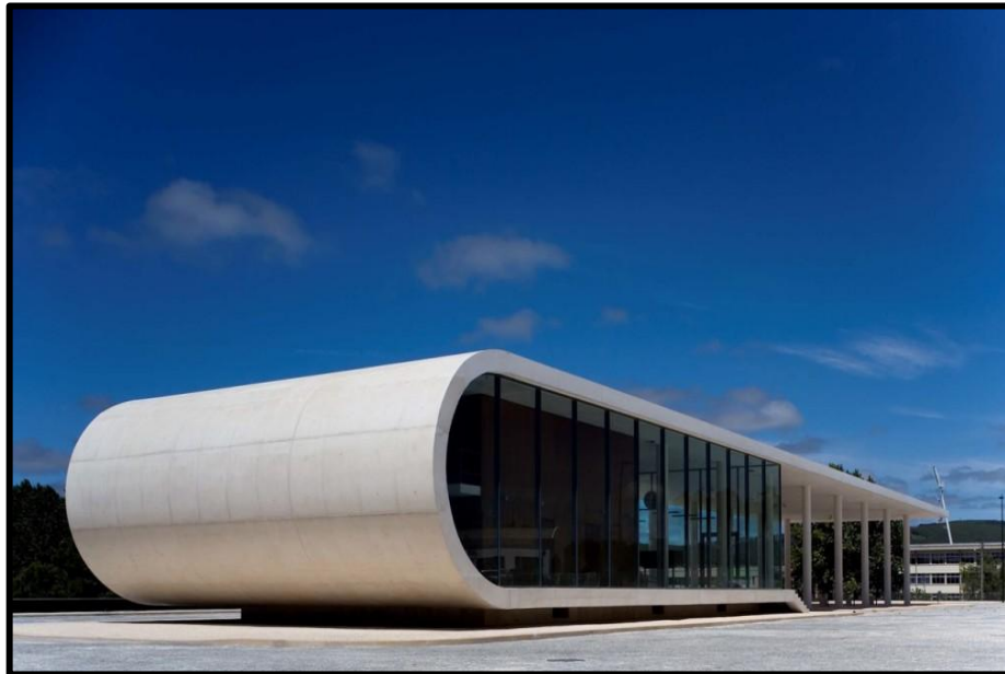
Figura 16. Terminal Rodoviário de Rio Maior
