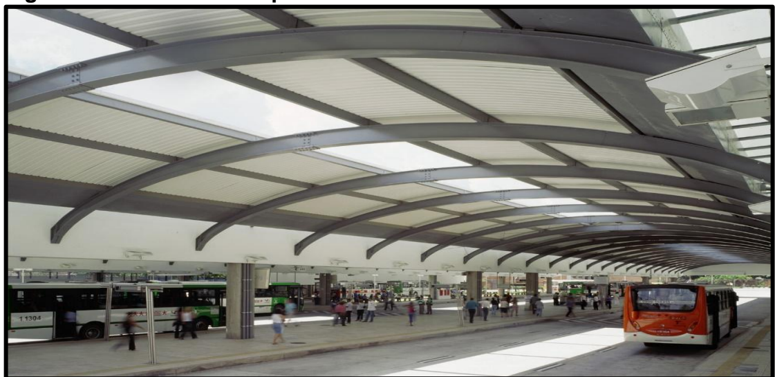
Figura 50. Cobertura das plataformas.
