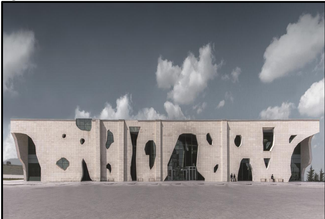
Figura 20. Terminal de Ônibus Nevsehir.
