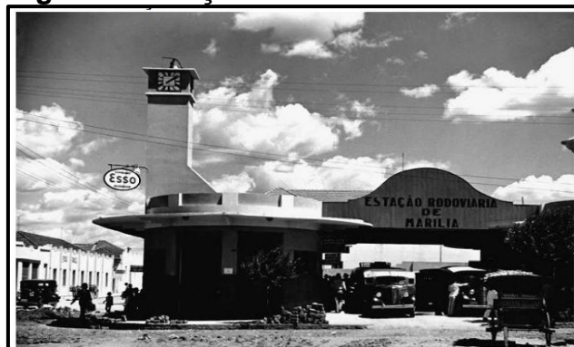
Figura 6. Estação de Marília-SP em 1938.
