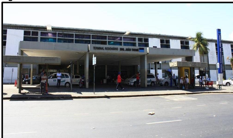
Figura 33. Rodoviária de Fortaleza
