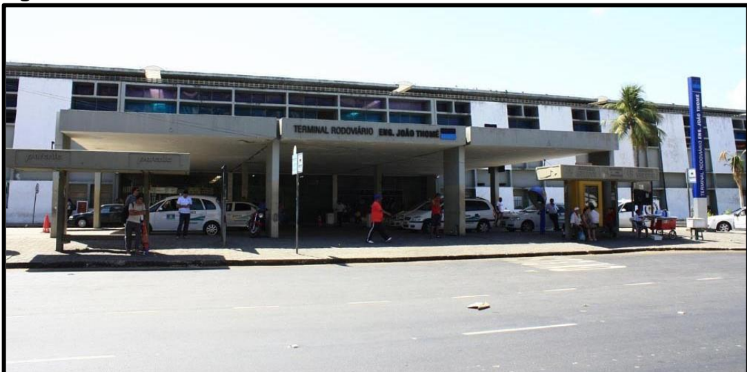
Figura 53. Rodoviária de Fortaleza.
