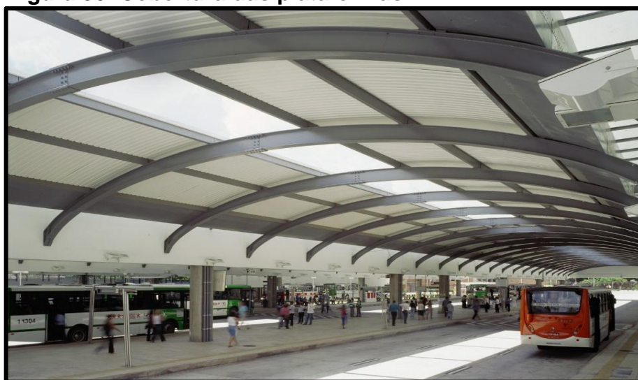
Figura 30. Cobertura das plataformas
